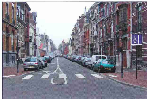
Signalisation de la sortie du double-sens cyclable : horizontale et verticale (C24a). Source : CETH Nord-Picardie
